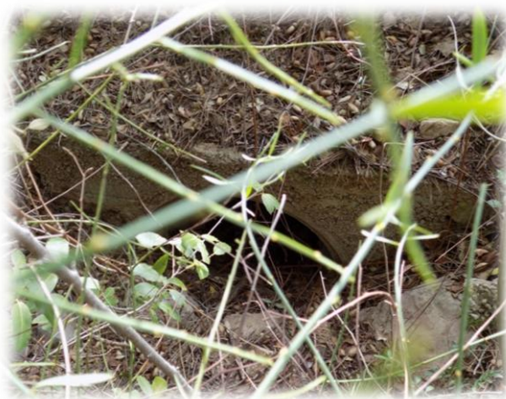
Système de canalisation entre deux mur en pierres sèches et buse envahis par la végétation
